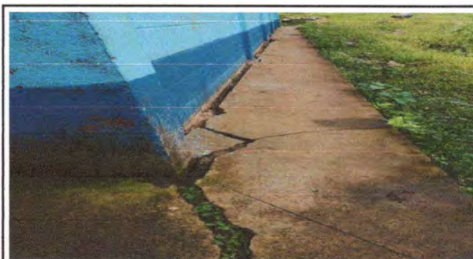
FOTO 4: REHABILITACIÓN DE PISO DE CONCRETO DEL MÓDULO 1
