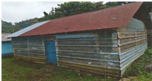
FOTO 1: REHABILITACIÓN DEL MÓDULO 3
