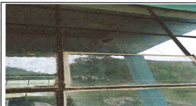
FOTO: 6 VENTANAS EN EL ÁREA DEL MÓDULO 2
