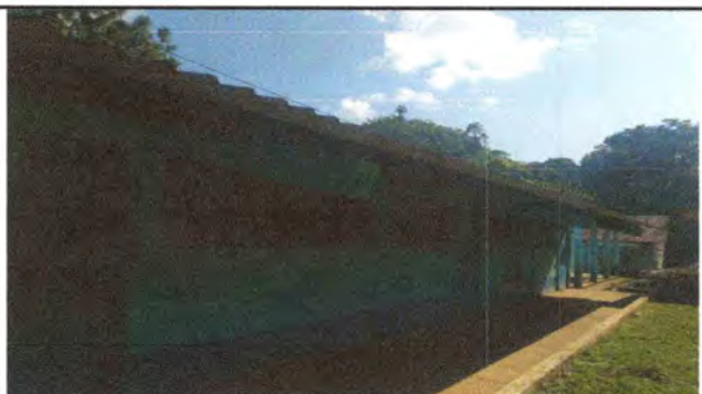
FOTO 3 :APLICACIÓN DE PINTURAS DEL MÓDULO 1
