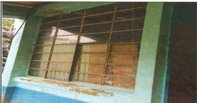
FOTO 5: VENTANAS EN EL ÁREA DEL MÓDULO 1
