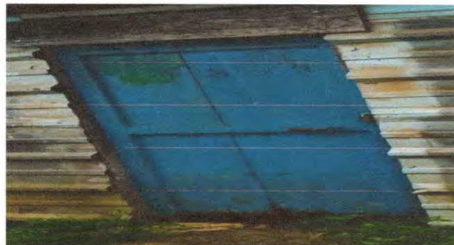
FOTO 2: SUSTITUCIÓN DE PUERTAS DE METAL DEL MÓDULO 3
